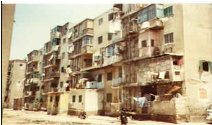
شكل (1- ب): (إضافة فراغات جديدة للمسكن- تفصيل البلكنات) إسكان عين الصيرة بالقاهرة، مصر [4]
