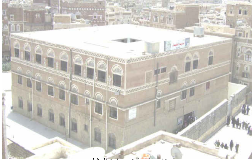
بناء مدرسة في حارة الوشلي
