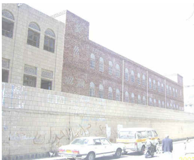
بناء مدرسة في حارة شارب
