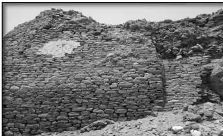
صورة (1-8) : بعض مواد البناء للقلعة وهي من الحجر المكسو بطبقة من الملاط الأبيض (البحص)
