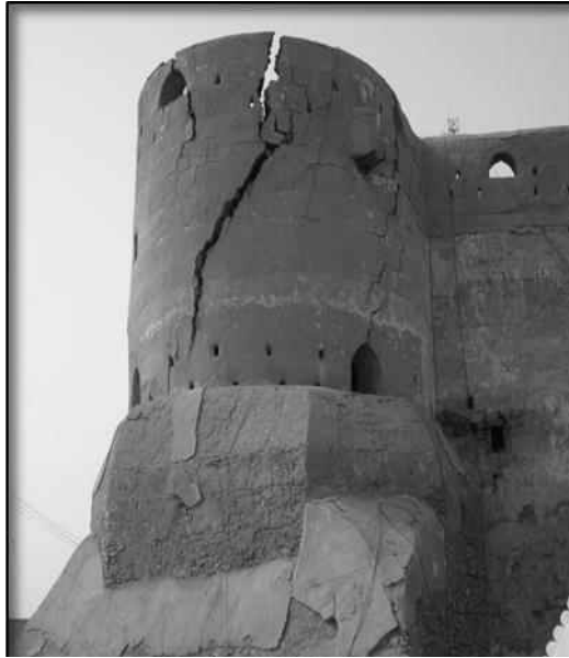
صورة (13) : انتشار الشقوق الرأسية الفاصلة بالحوائط الخارجية للقلعة
