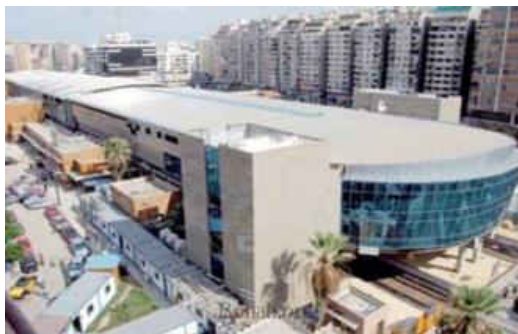
شكل(9) 18 : تطوير محطة قطار سيدي جابر 2013.
