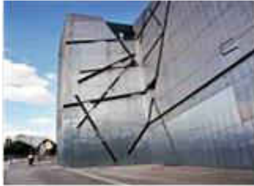
شكل(4): يوضح استخدام الخرسانة الظاهرة كمصدر للإبداع في الواجهات لمتحف جيوش 1989م (38)
