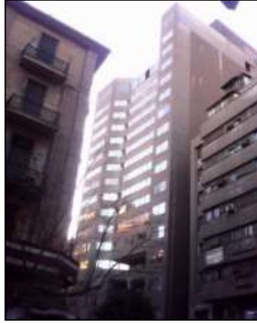
شكل (16): مبنى إيفرجرين
