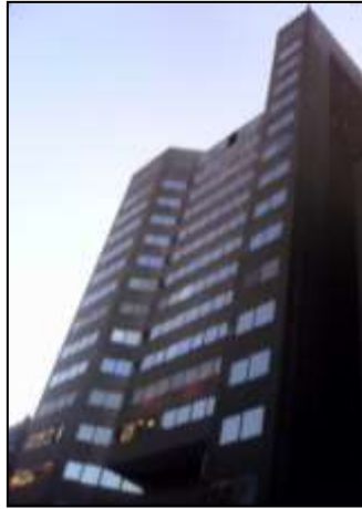
شكل (25): مبنى إيفرجرين
