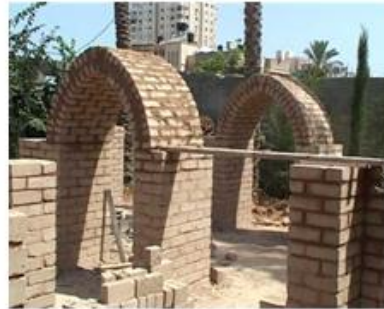
شكل رقم (2): يوضح الإنشاء بطريقة الحوائط الحاملة بالطوب، المصدر [18]
