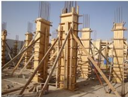
شكل رقم (3): يوضح الإنشاء بطريقة المباني الهيكلية، المصدر [18]
