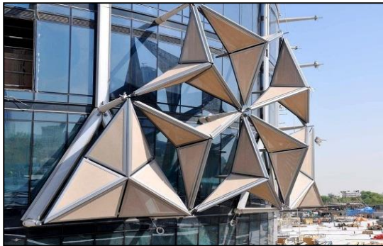
شكل (20): التحكم الذكي بكاسرات أشعة الشمس
