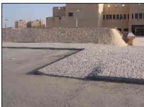
الشكل رقم (10): يوضح أحد المنحدرات الغير نظامية المؤدية إلى الرصيف بالدور الأول لكلية العمارة والتخطيط.
