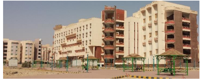
صورة فوتوغرافية للواجهة الجنوبية الخاصة بكلية الآداب
