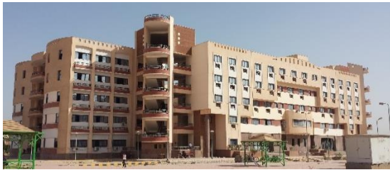
صورة فوتوغرافية للواجهة الجنوبية الخاصة بكلية التربية
