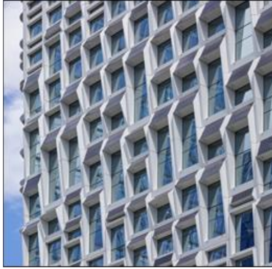
شكل ١٠: الواجهة الجنوبية لمبنى Hanwha Headquarters Remodelling التي يظهر بها مواقع الألواح الضوئية أعلى النوافذ [٢٥].
