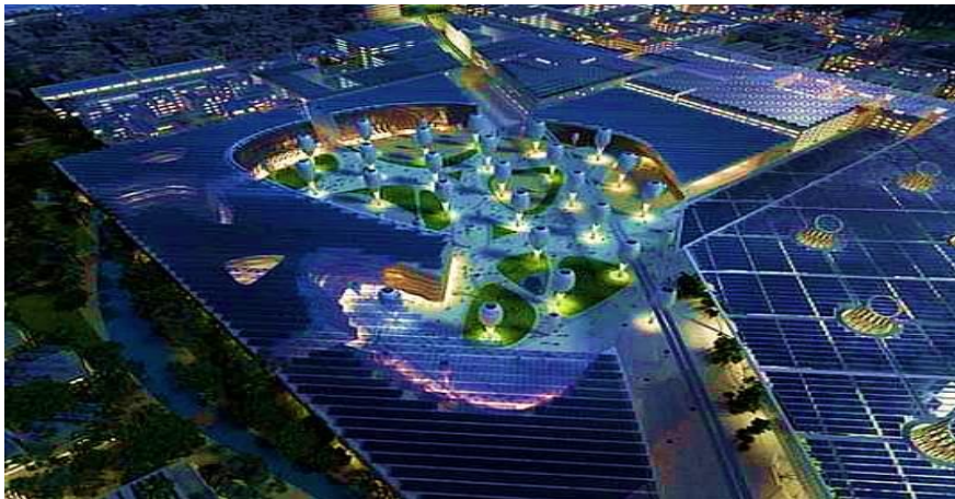
شكل (١٥) استخدام مسطحات شاسعة من الخلايا الكهروضوئية على أسطح المباني بمدينة مصدر. [٢٢]
