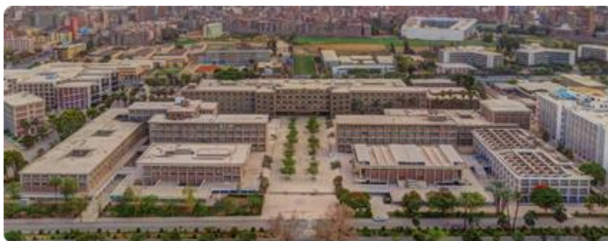
واجهات مباني كلية الهندسة [٢١]
