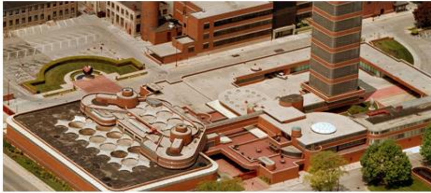
صورة جوية للمبنى [٣٩]
