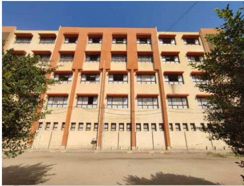
شكل (٧) الواجهة الغربية للمبنى المدرسي
